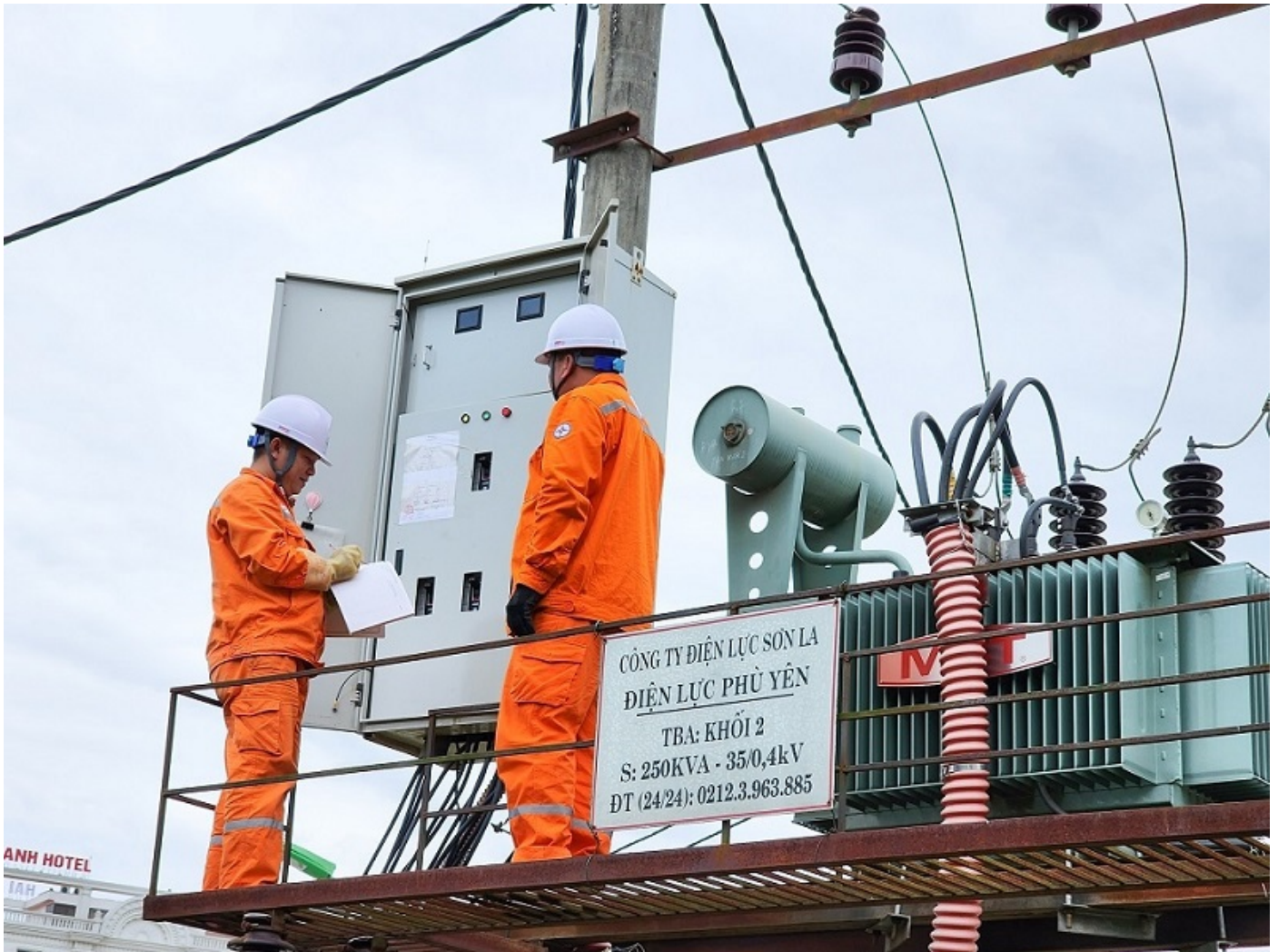
Công nhân PC Sơn La kiểm tra thông số kỹ thuật trạm biến áp
