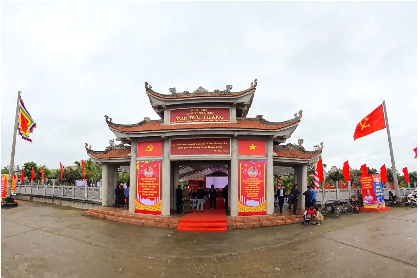
Công trình Nhà lưu niệm Chủ tịch Tôn Đức Thắng tại xã Tiên Cường, huyện Tiên Lãng, thành phố Hải Phòng.
