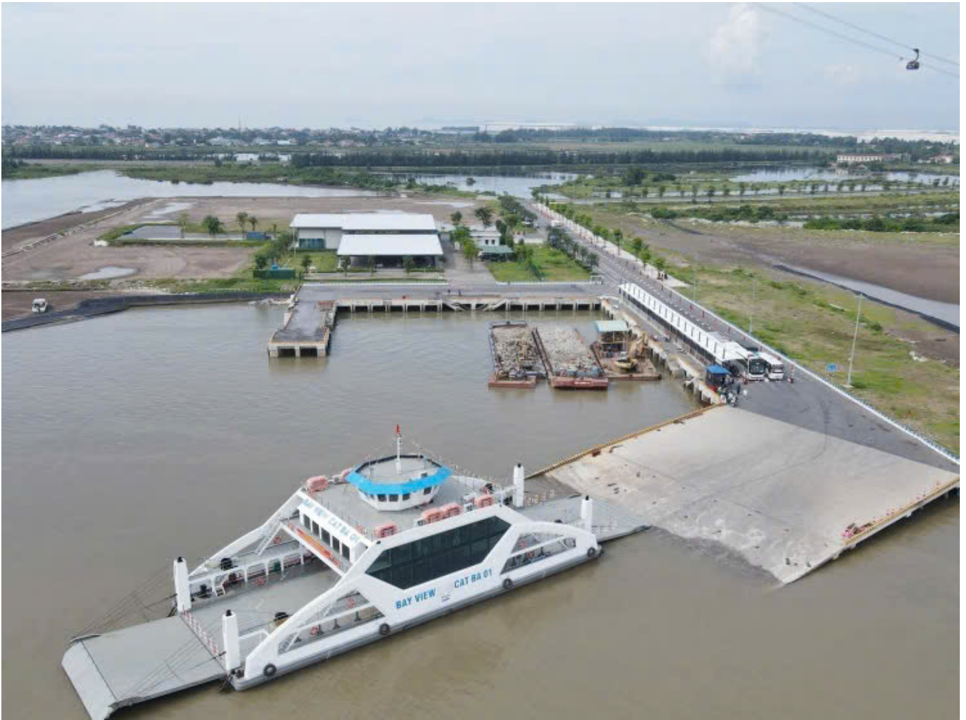
Bến phà Đồng Bài cùng phà mới Bay View Cat Ba vận hành giúp cải thiện được tình trạng tắc phà trước đây_Ảnh: Lê Tân
