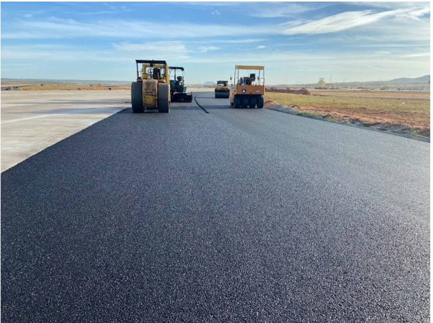
Tracodi đang thi công dự án sân bay Phan Thiết
