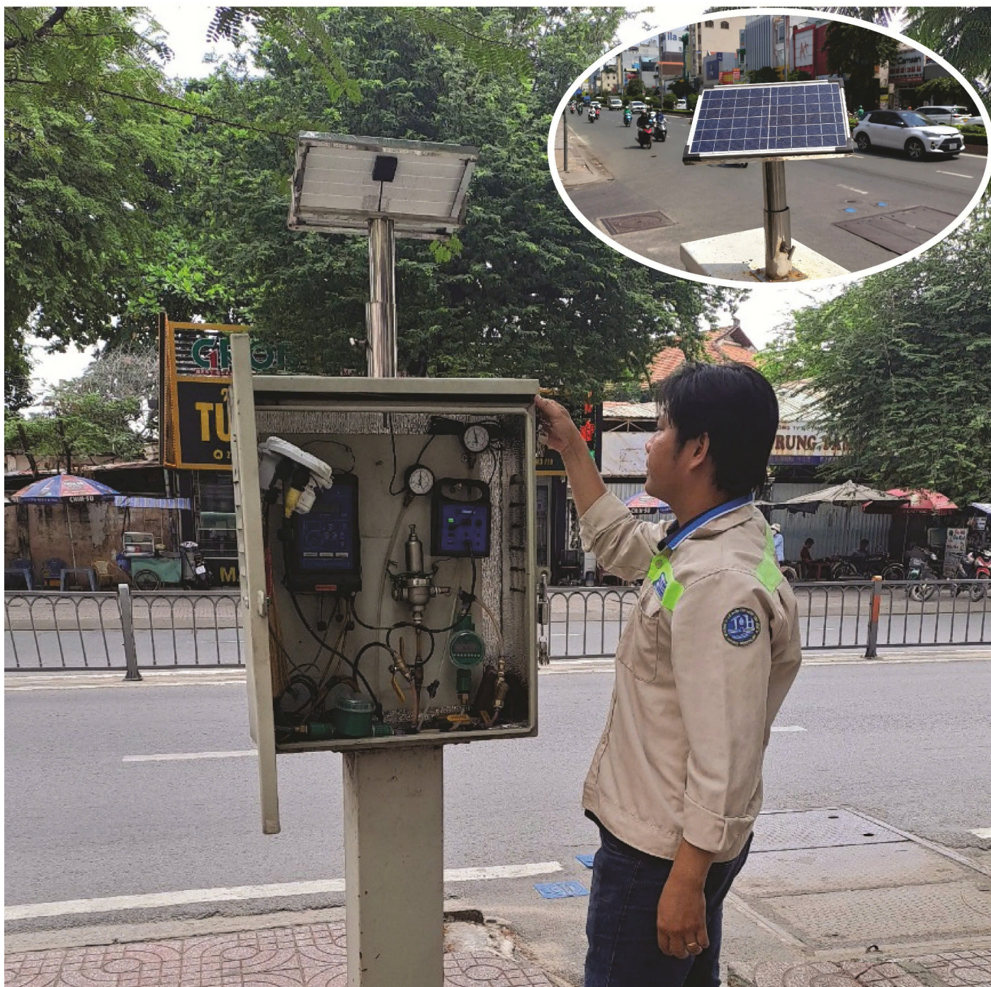
Nhân viên Caretaker Công ty CPCN Tân Hòa đang setup Pin Solar tại quận Tân Phú, TP. HCM
