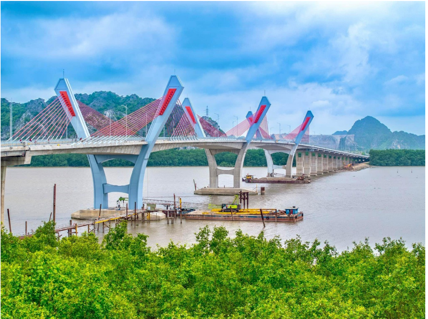
Cầu Bến Rừng sắp hoàn thành và đưa vào sử dụng
