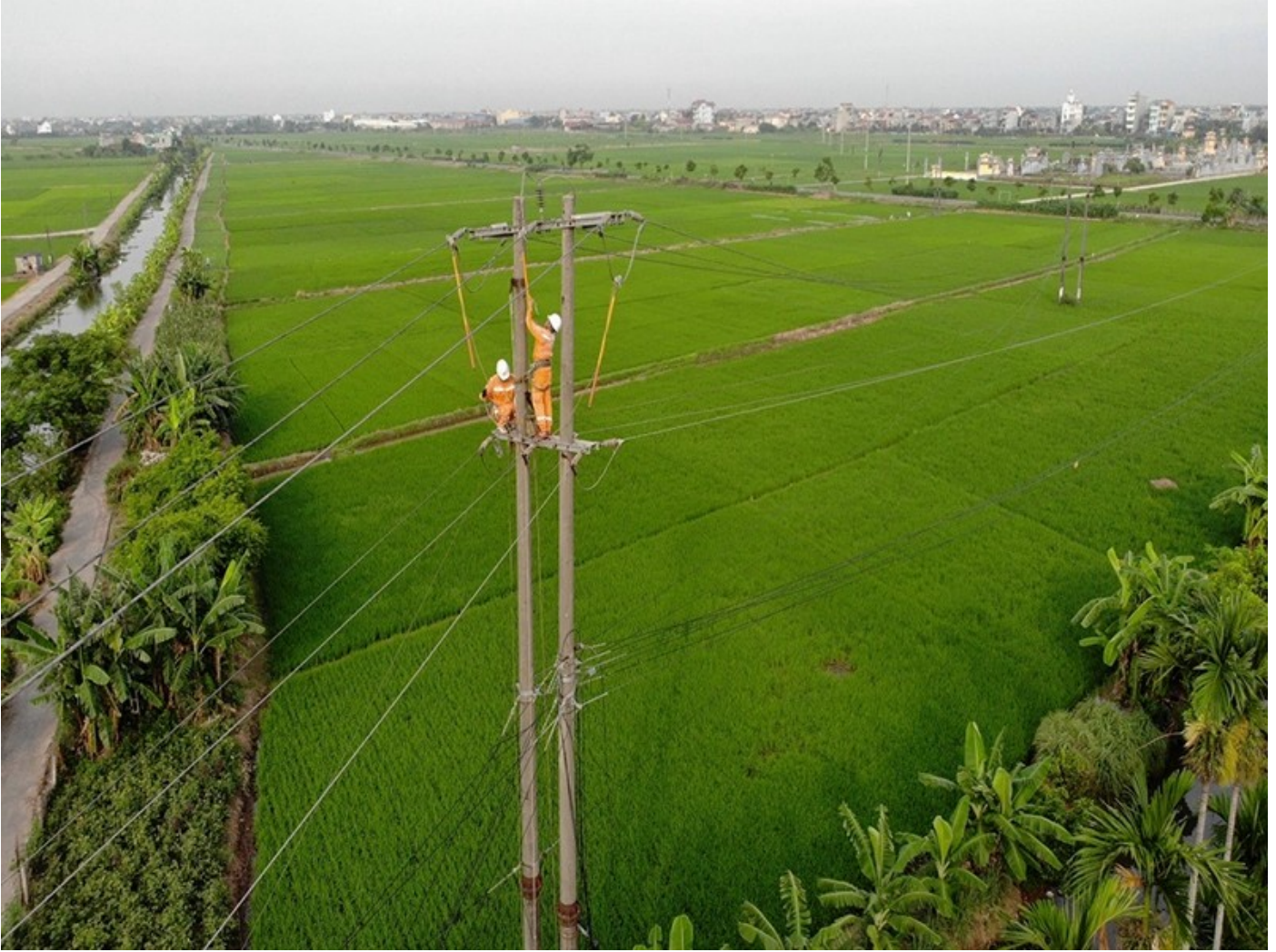
Công nhân Điện lực Hải Hậu, Nam Định kiểm tra sứ lộ trên đường dây trung thế 22 kV.
