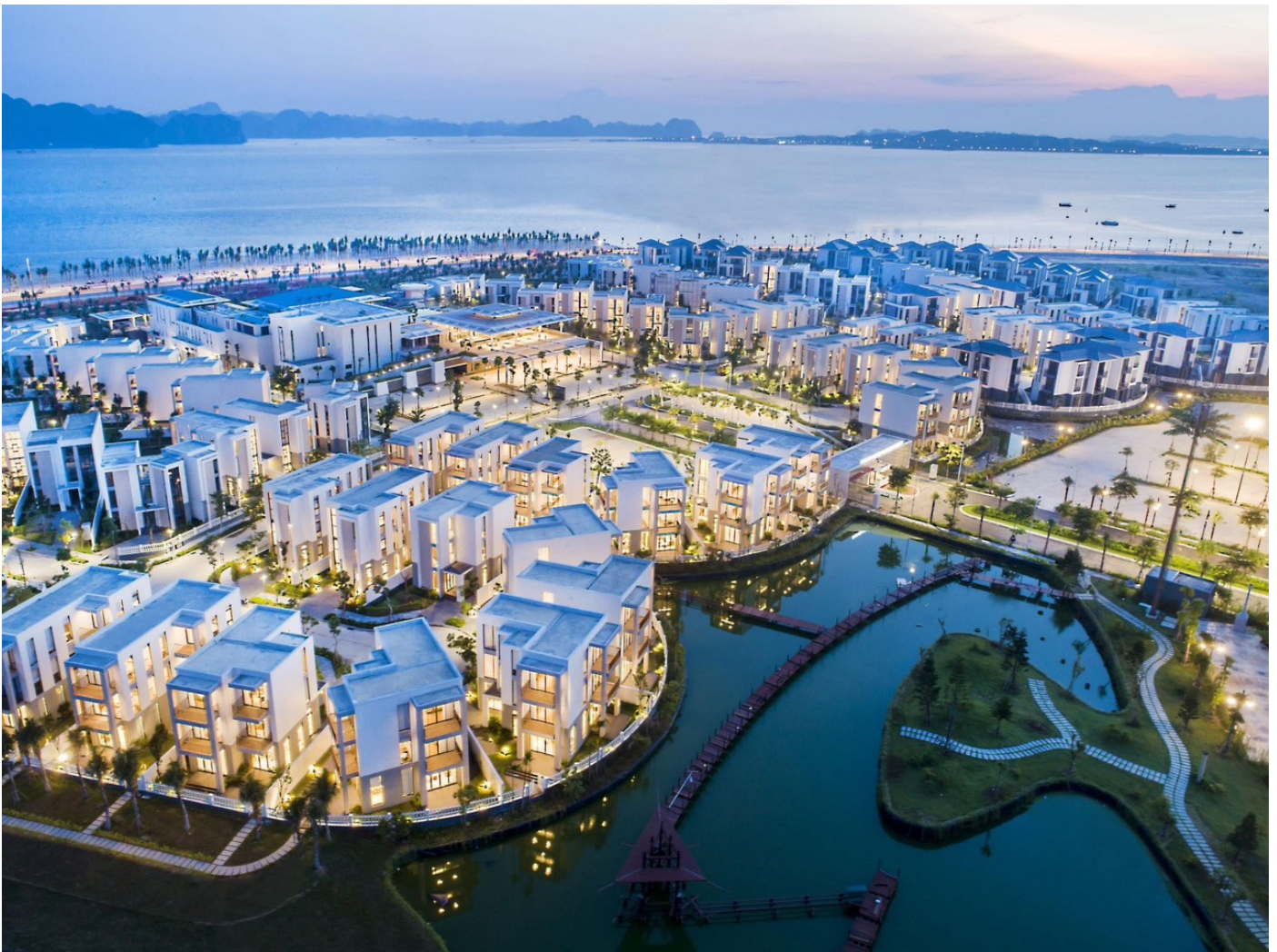
Toàn cảnh Oakwood Ha Long
