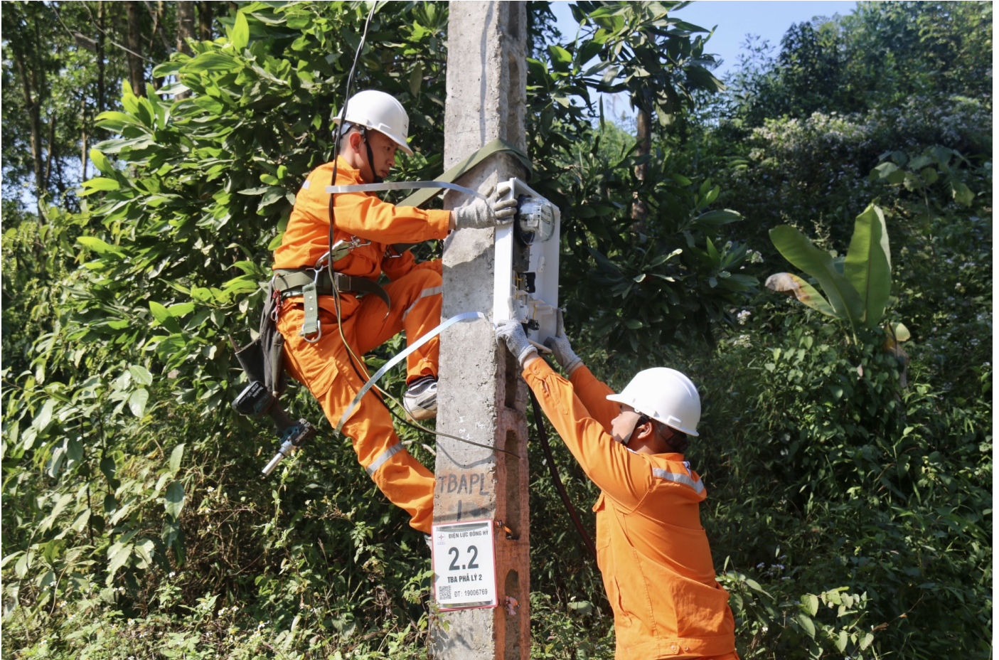
Công nhân Công ty Điện lực Thái Nguyên lắp đặt công tơ điện tử đo xa
