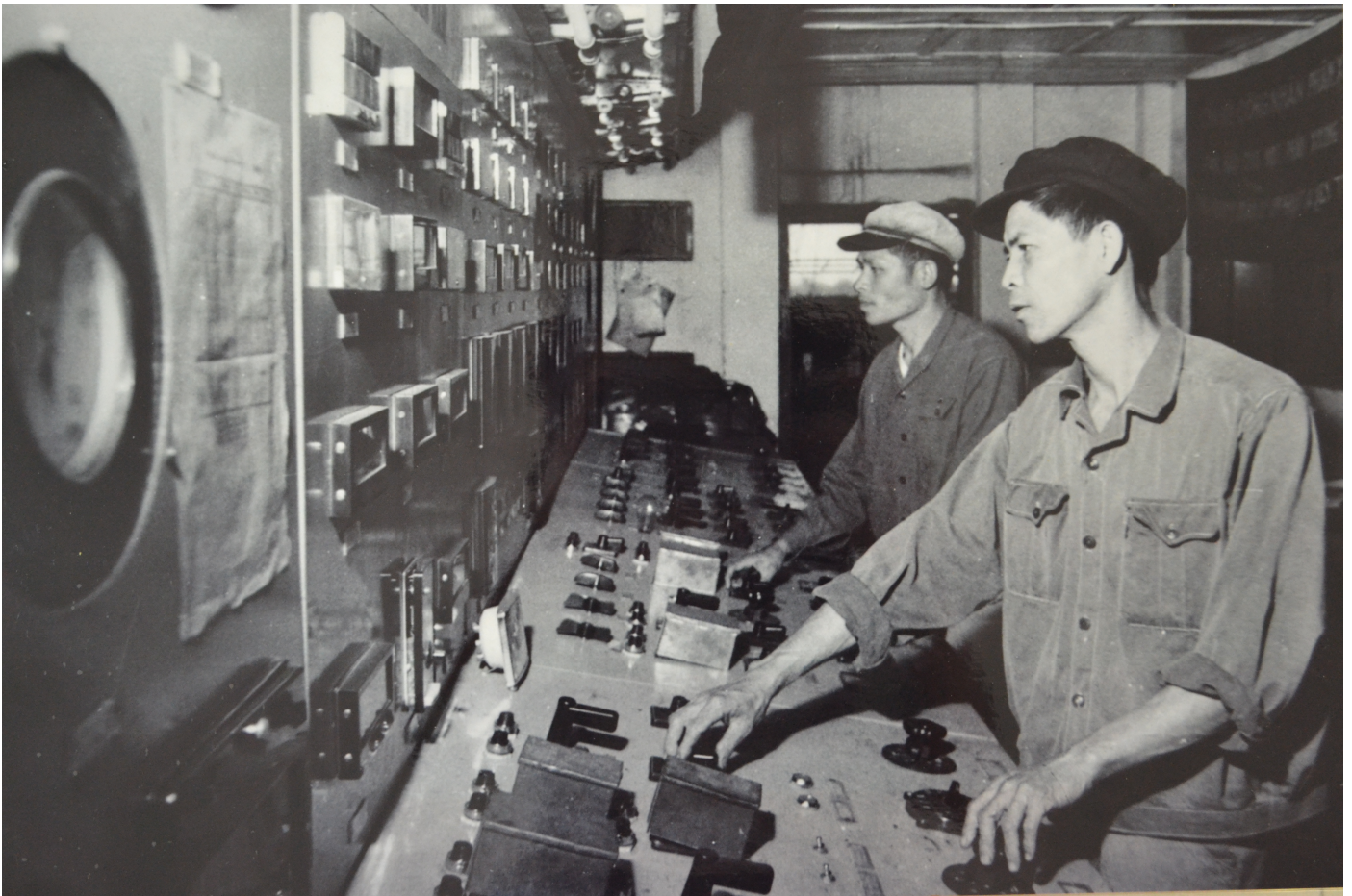
Trung tâm vận hành điện Nhà máy điện Thái Nguyên năm 1963
